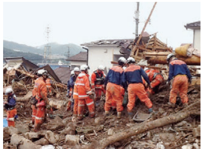
広島市土砂崩れ現場における活動 (緊急消防援助隊愛媛県大隊提供)
