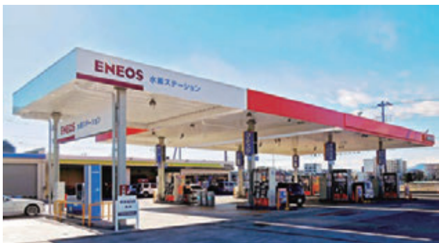
水素ステーションを併設する給油取扱所
